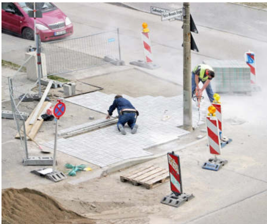
Absenken der Bordkanten 2013 für besseres Rollen der Rollatoren und Rollstühle
