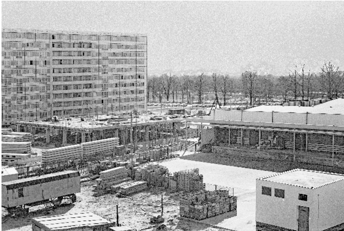
Rechts die fertige KONSUM-Kaufhalle, links das Dienstleistungszentrum im Bau
