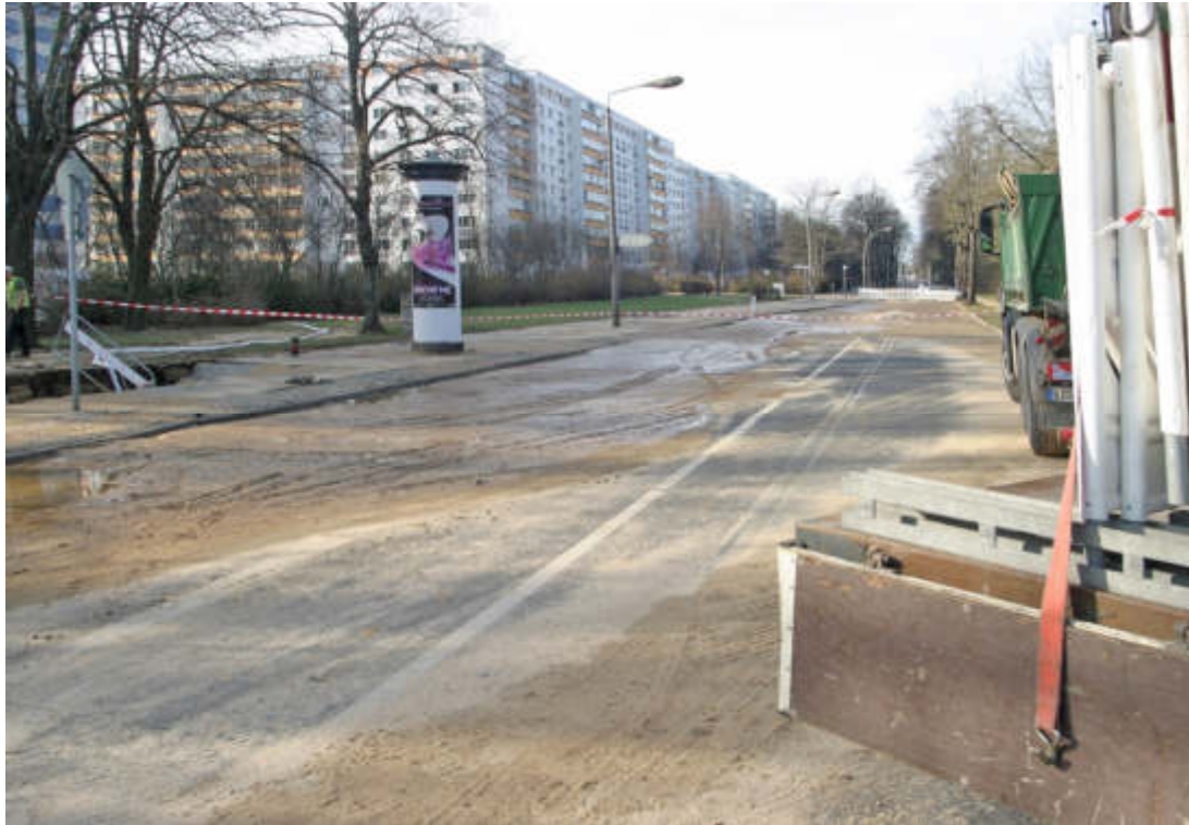
Wasserrohrbruch 2013, zwei Wochen Sperrung der Salvador-Allende-Straße
