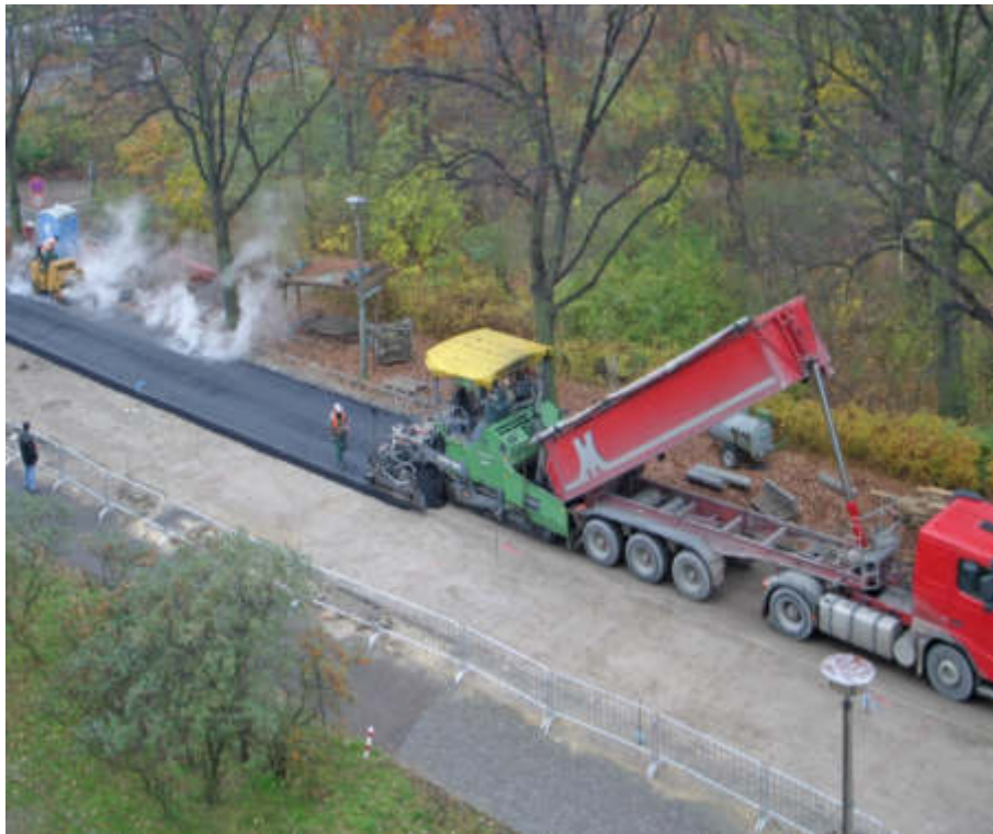
Erneuerung der Pablo-Neruda-Straße 2005
