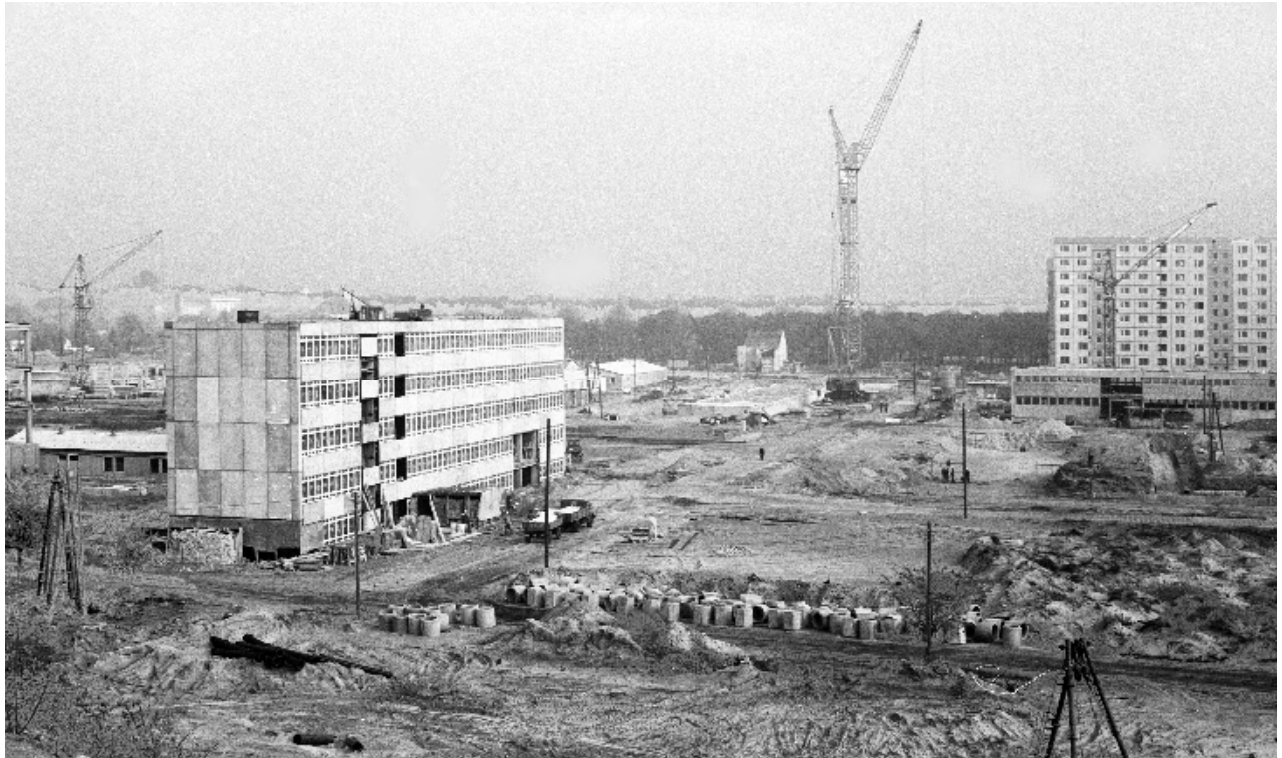
Bau der 25. Oberschule, später Salvador-Allende-Schule, heute: Emmy-Noether-Gymnasium
