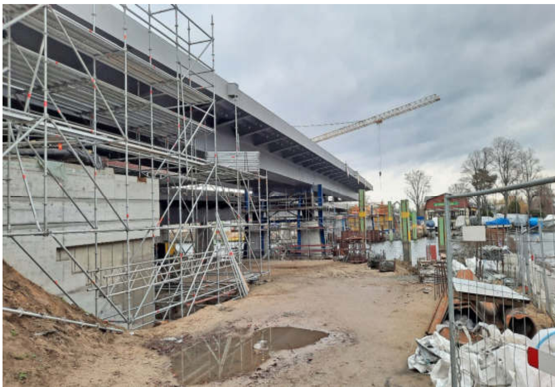
Rekonstruktion der Salvador-Allende-Brücke über die Müggelspreewälder (2018-2022)
