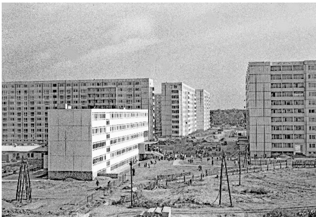
Schule und Wohnblöcke kurz vor der Fertigstellung
